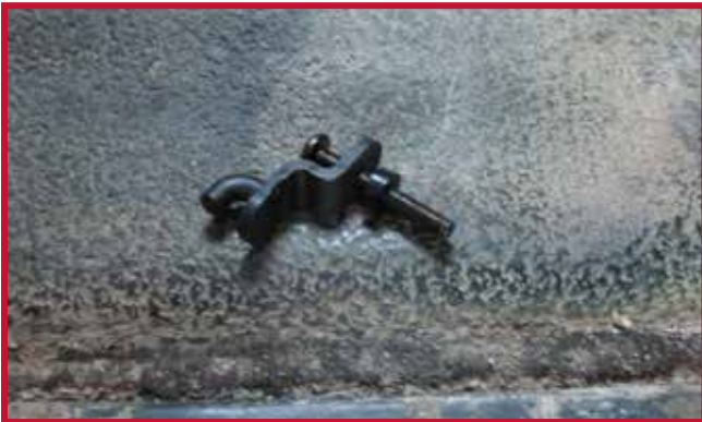
Figura 7 - Conjunto de gancho y espaciador
